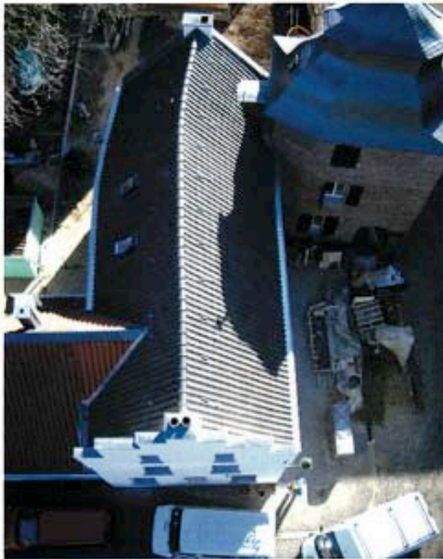
Blick auf die Dächer
