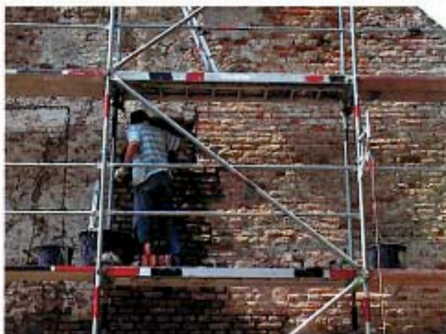
Arbeiten an der Südfassade
