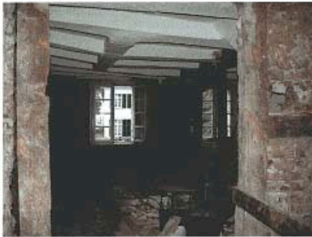
Zimmer im 1. Obergeschoss vor ...
